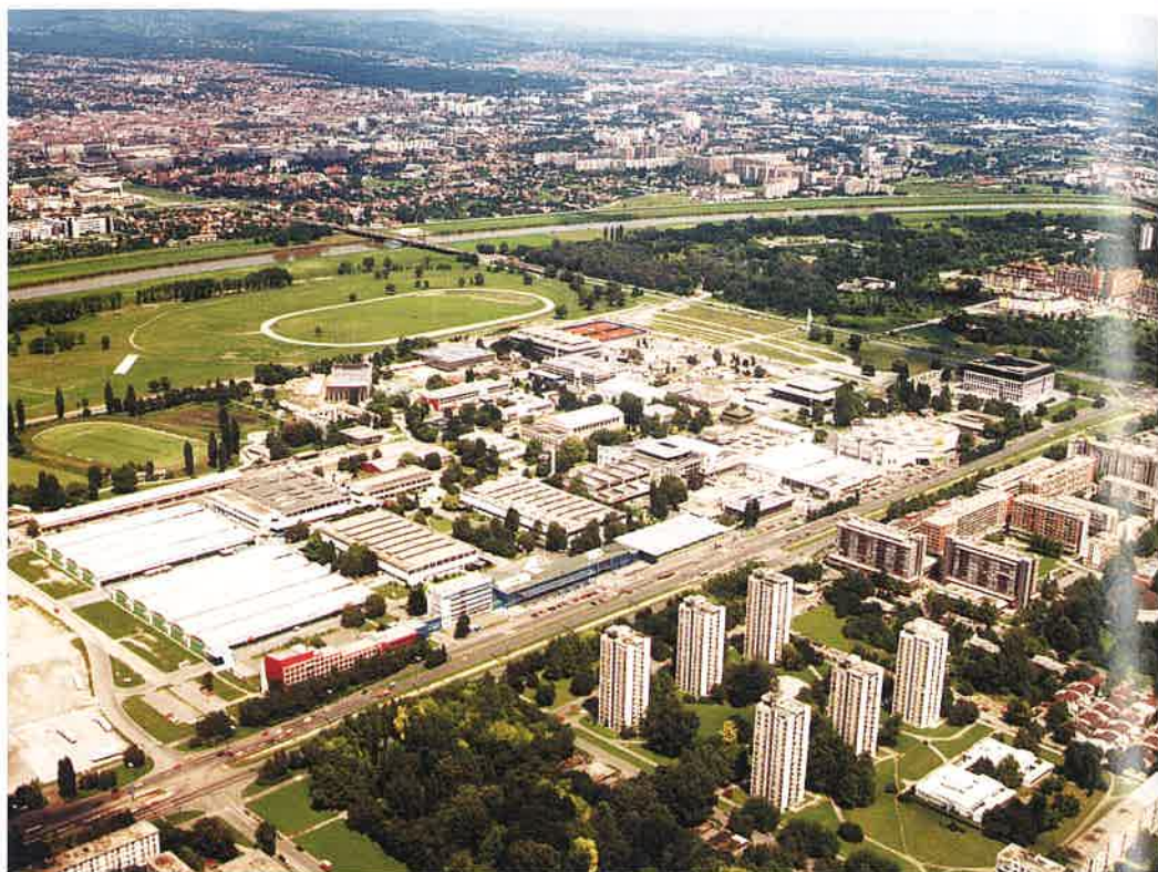
Južni dio savske nizine na području Novoga Zagreba s gradskom četvrti Siget, kompleksom Zagrebačkoga velesajma i Hipodromom, lijevo od Avenije Većeslava Holjevca (u produžetku Most slobode) te stambenim blokovima četvrti Središće i zelenim pojasom Bundeka, u stražnjem planu desno.
