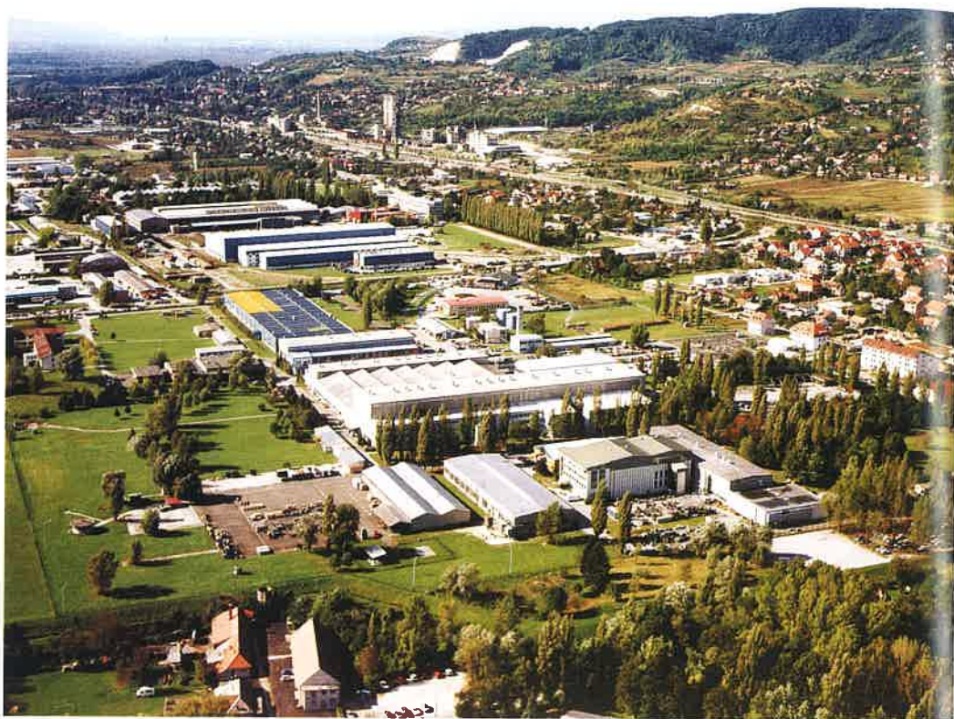
Zapadna industrijska zona Zagreba - Jankomir južno od "stare" Samoborske ceste na području Susedgrada.
